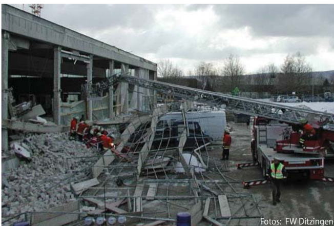
Bei der Erstversorgung eines Verschütteten durch Einsatzkräfte der Feuerwehr sind lebensbedrohliche Blutungen vordringlich zu behandeln
